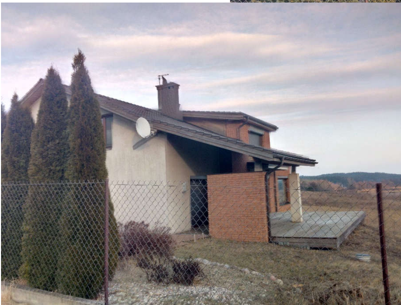
Fot. 6 i 7. Zabudowa mieszkaniowa w zachodniej części obszaru opracowania (źródło własne).
